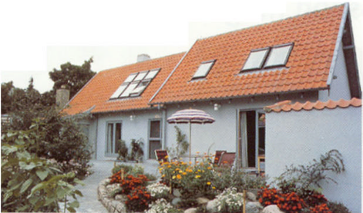
Fig.1. Fotografia unei case realizata din placi prefabricate
