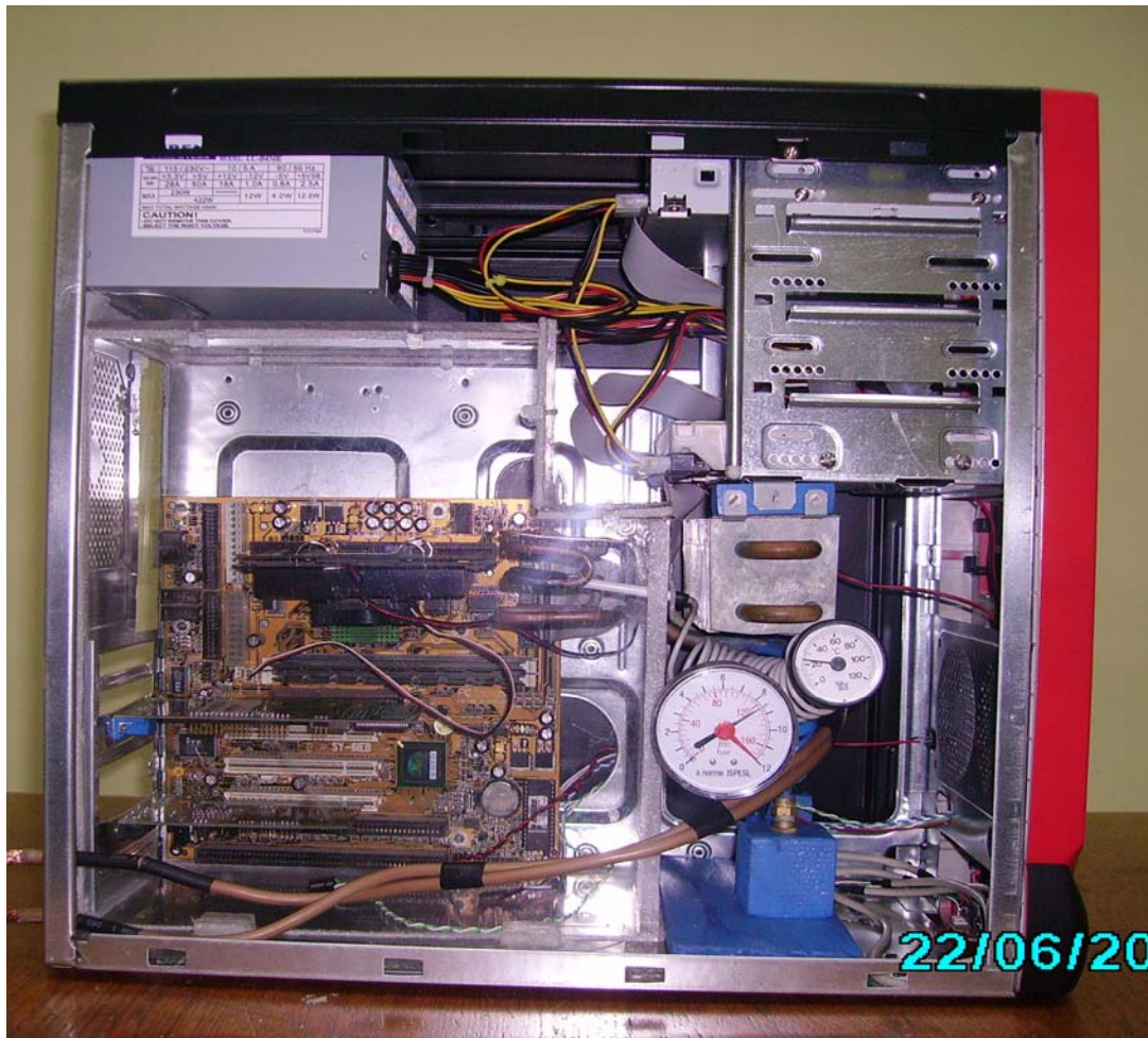
Fig. 12 L'ordinateur refroidi à l'aide d'un mini installation frigorifique
